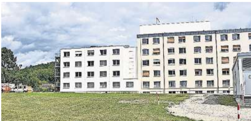
Der Hubschrauberlandeplatz von St. Barbara befindet sich auf der Rückseite des Krankenhauses.
